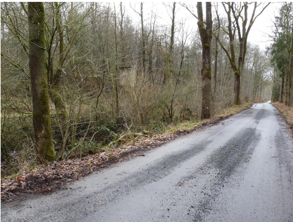
Standort auf der „Alten Hauptschwendaer Straße“, die nördlich des Geltungsbereiches verläuft, Blick von O nach W; die Straßenbäume und der Entwässerungsgraben gehören zur Wegeparzelle der „Alten Hauptschwendaer Straße“; links des Grabens und der Sträucher liegt die nördliche Geltungsbereichsgrenze; der hinter den Sträuchern zu sehende Hochsitz steht auf der Fläche (Aufnahme Feb. 2025)
