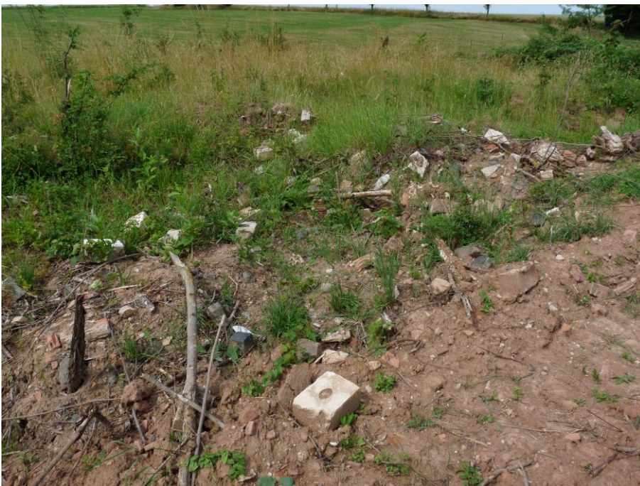
Blick auf die Beschaffenheit des aufgeschütteten und planierten Oberbodens: Lehm, Basalt-schotter, Flussskies, Ziegelsteine, Betonsteine, Leichtbetonsteine (Juli 2023)
